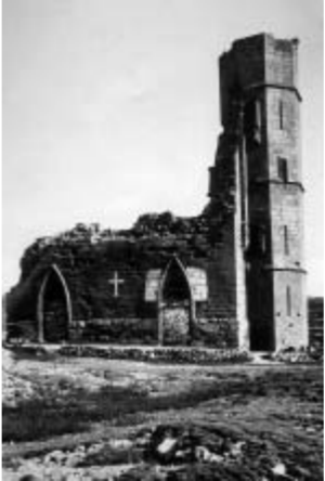
Palacio de Pedro IV antes de su rehabilitación
