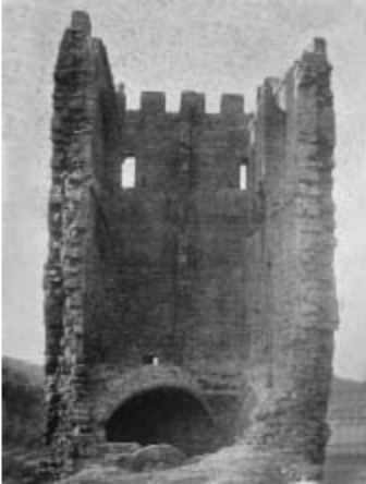
Torre del Homenaje antes de su rehabilitación
